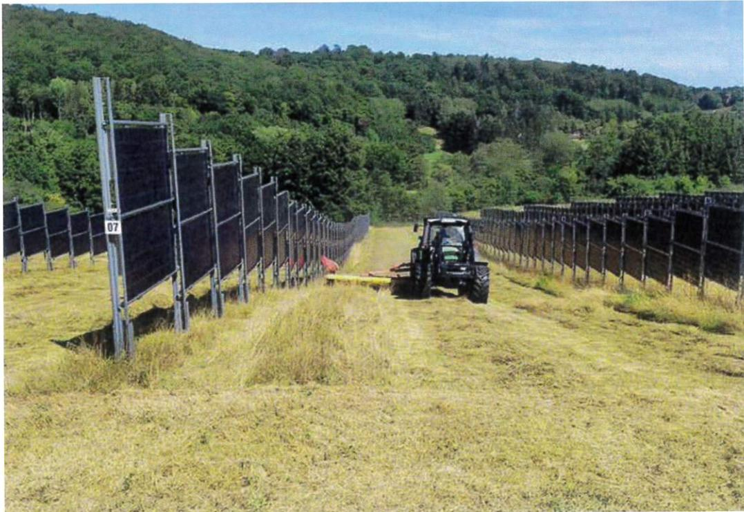
Abbildung 6: Foto einer bifacialen Freiflächenphotovoltaikanlage, Next2sun
