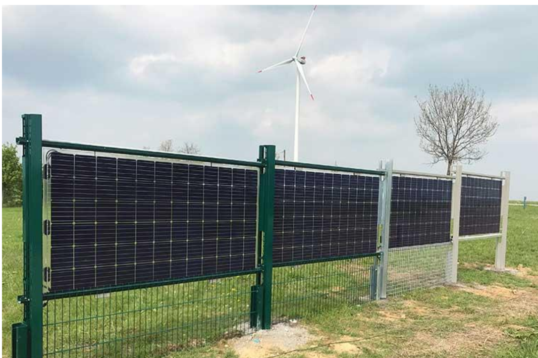
Abbildung 7: Foto eines Solarzaunes, next2sun
