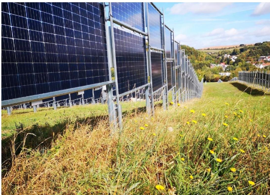
Abbildung 8: Blüh- Altgrasstreifen beidseitig der bifacialen Modulreihen
