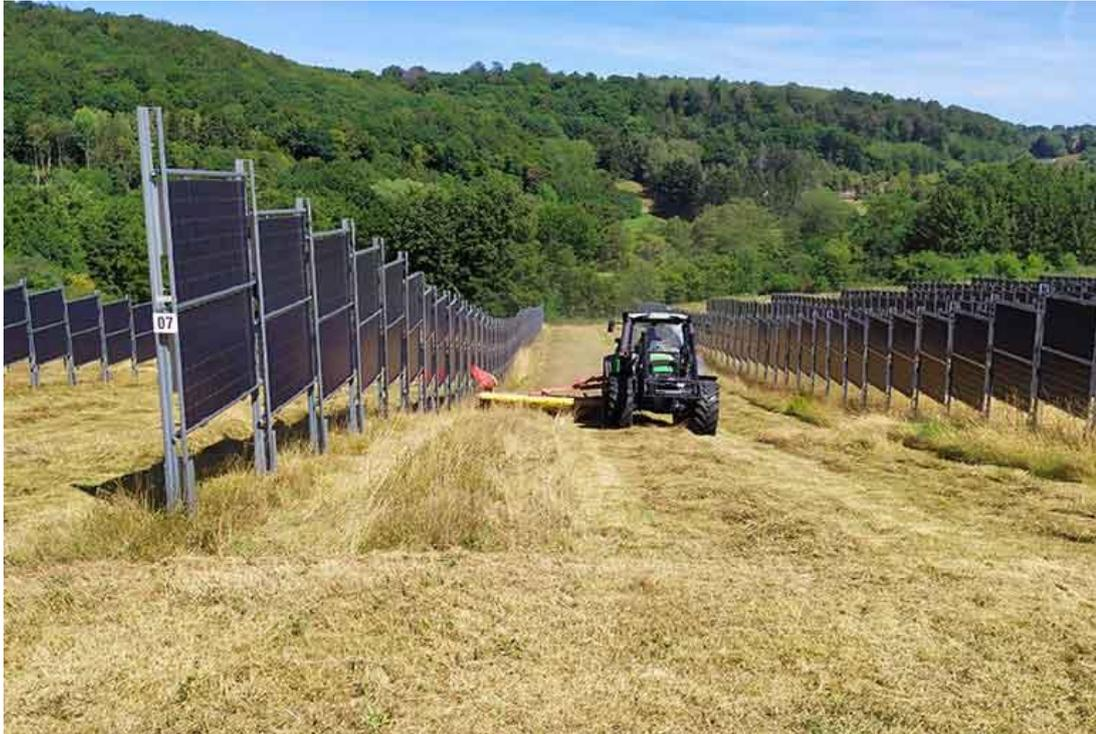
Abbildung 6: Foto einer bifacialen Freiflächenphotovoltaikanlage, Next2sun
