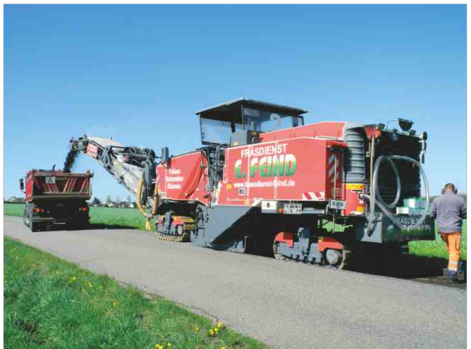
Modernste Frästechnik der Firma Fräsdienst E. Feind im Einsatz auf der Jahnsdorfer Straße in Adorf
