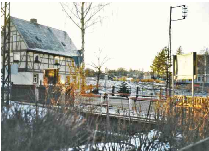
Abriss der Färberei
