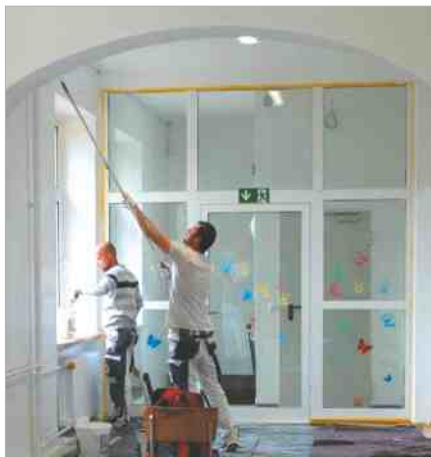
umfangreiche Malerarbeiten im Schulgebäude
