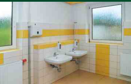
Waschbereich nach der Sanierung
