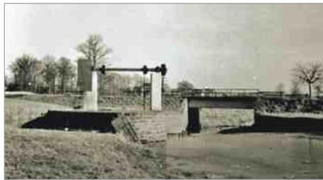
Die 1940 errichtete neue Brücke, davor das 1950 gebaute neue Wehr mit einer Stauklappe
