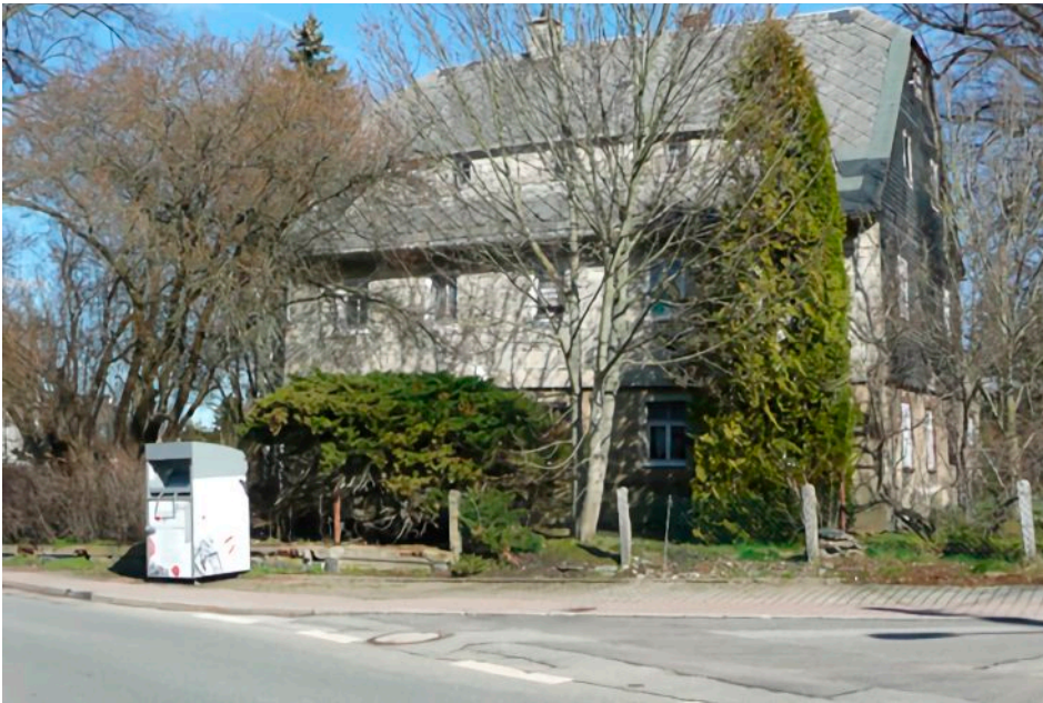
Ansicht von der Adorfer Hauptstraße
