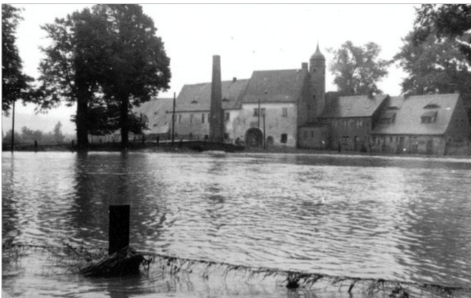
Abb. Hochwasser 1954 am Wasserschloss Klaffenbach
