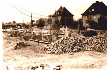
AWG Waldstraße 5-7, Baubeginn 1958
