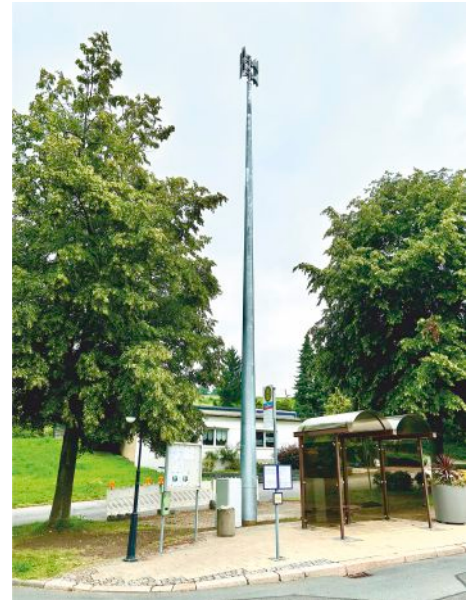
Neue Sirene am Buswendeplatz Adorf
