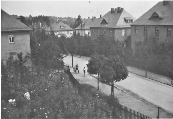
Gartenstadt Vorgarten der Häuser 16 - 18
