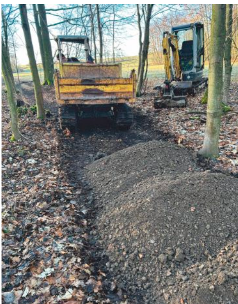
Einbau des Frostschutzes
