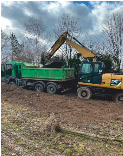
schwere Technik im Einsatz
