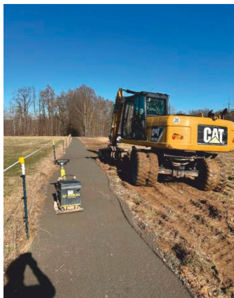
schwere Technik auf der Baustelle
